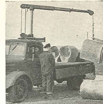
Materialerne skal ankomme til byggepladsen efter nøjagtig plan. Er der forsinkelser forrykkes hele byggeprocessens forløb.
